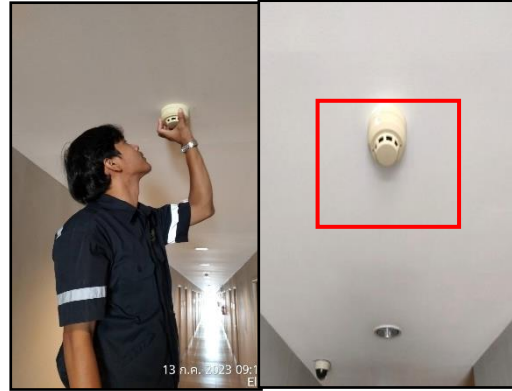
ภาพที่ 29 Smoke Detector
