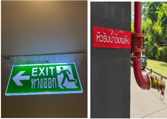
ภาพที่ 33 ป้ายบอกทางหนีไฟ, หัวรับน้ำดับเพลิง
