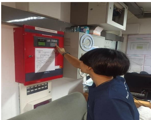
ภาพที่ 20 Fire Alarm Control Panel
