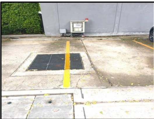
ภาพที่ 34 ตะแกรงดักขยะที่ Man Hole(ต่อ)
