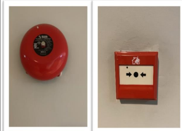
ภาพที่ 19 Alarm Bell, Manual Station
