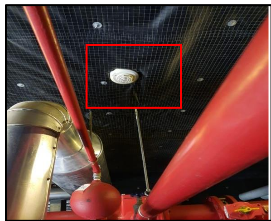
ภาพที่ 32 Heat Detector
